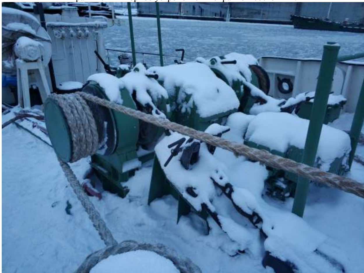
Брашпиль и якорное устройство в исправном состоянии.
