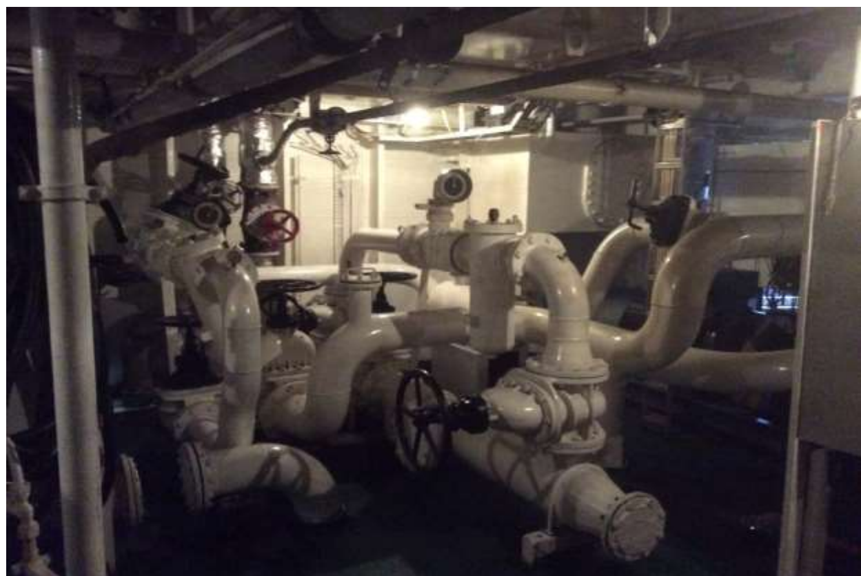
2 рабочих насоса ( 240 м 3 в час) в исправном состоянии. Счётчики калиброваны.
